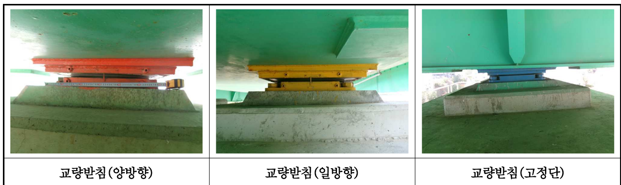
【사진 3.3.13】 교량받침 전경
