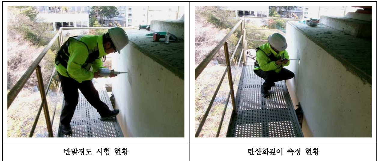
【사진 3.4.1】 콘크리트 내구성조사 현황
