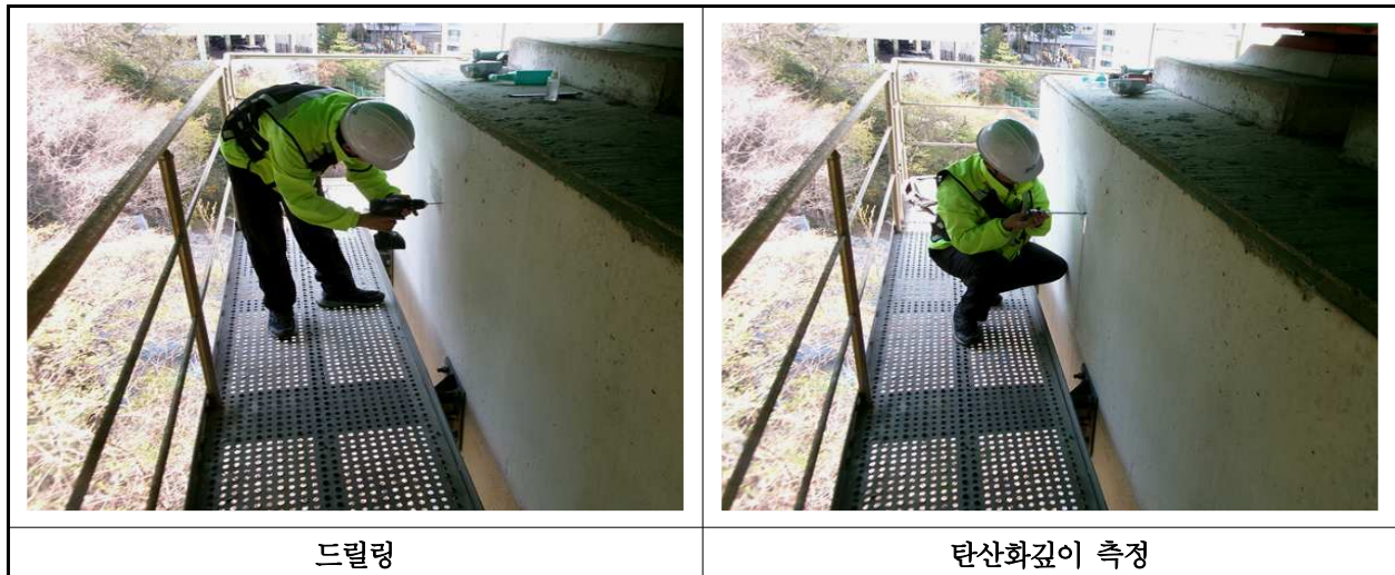
【사진 3.4.3】 탄산화 깊이 측정 현장사진
