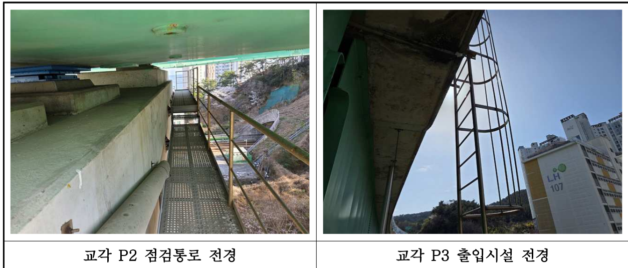
【사진 3.3.26】 교량 점검시설 전경
