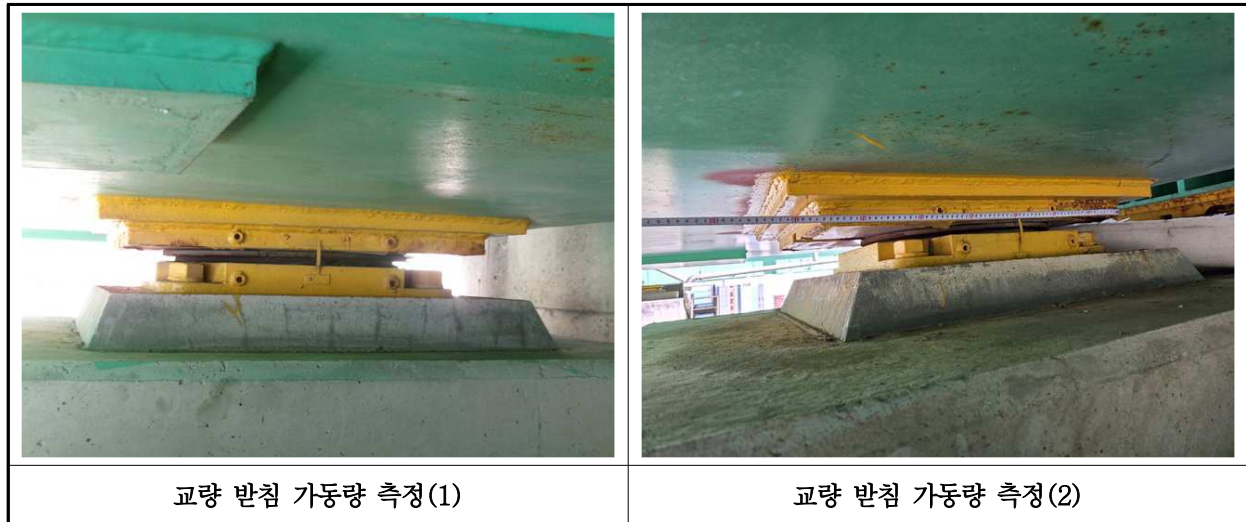
【사진 3.3.16】 교량받침 이동량 측정
