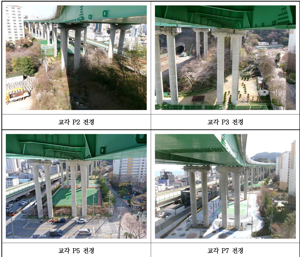
【사진 3.3.10】 교각 전경
