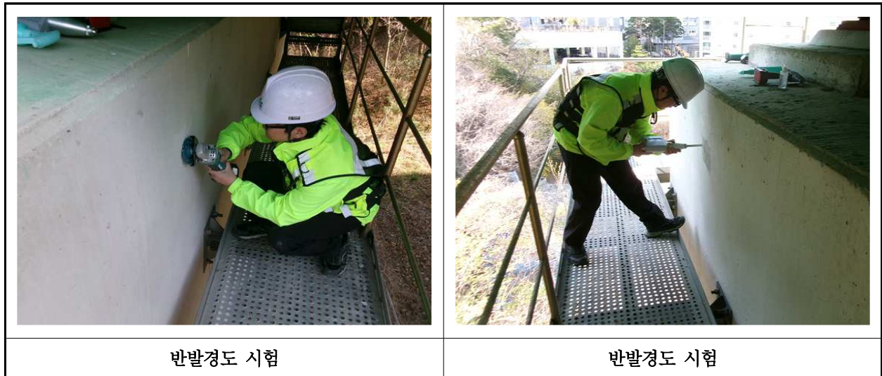
【사진 3.4.2】 반발경도시험 현장사진
