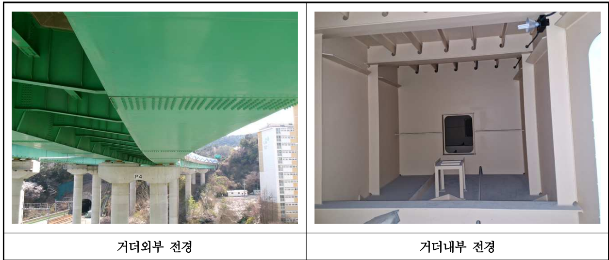
【사진 3.3.4】 거더 전경
